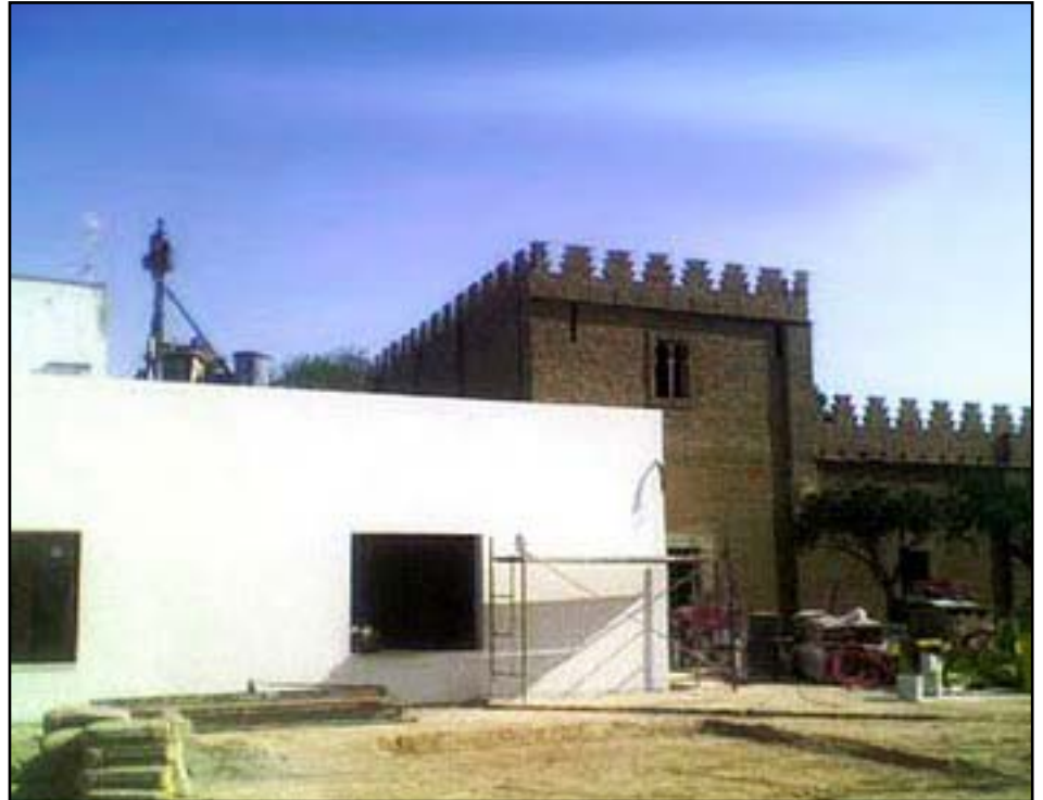
Cachivache que la Junta de Andalucía está construyendo delante de Villa Alegría, casa de Blas Infante en Coria.
